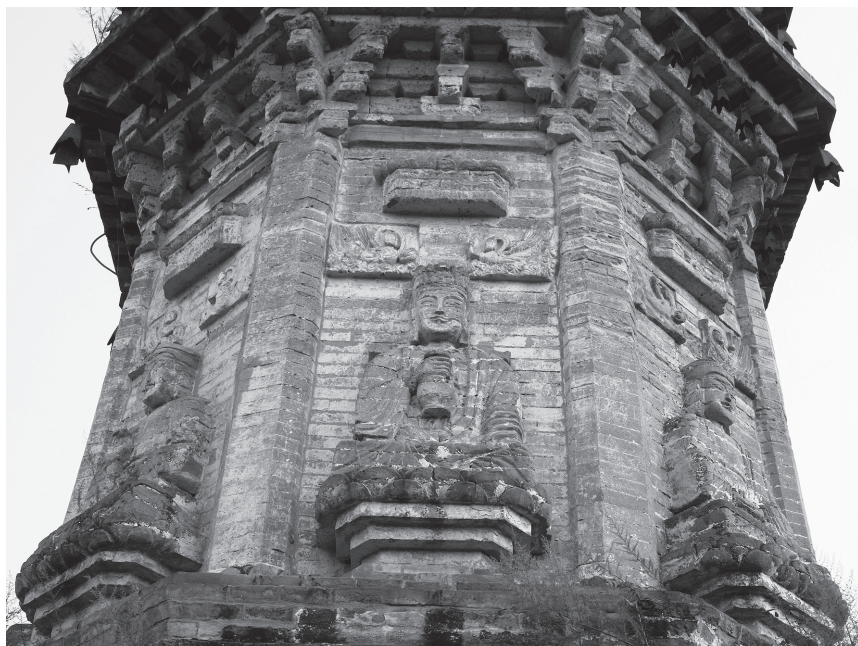
PL.3 (上) 塔湾塔初層南壁・PL.4 (下) 塔湾塔初層西北壁
